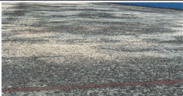
Foto1: CAMBIO DE LOSA DE PATIO
