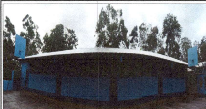
Foto 4: IMPLEMENTACIÓN DE CANAL
