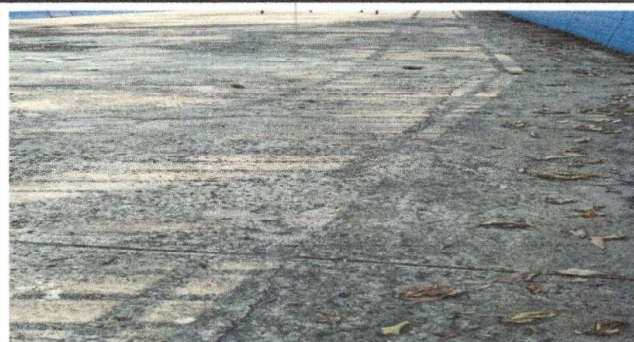
Foto 2: CAMBIO DE LOSA DE PATIO
