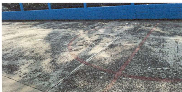
Foto 3: CAMBIO DE LOSA DE PATIO
